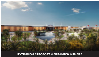
EXTENSION AÉROPORT MARRAKECH MENARA
