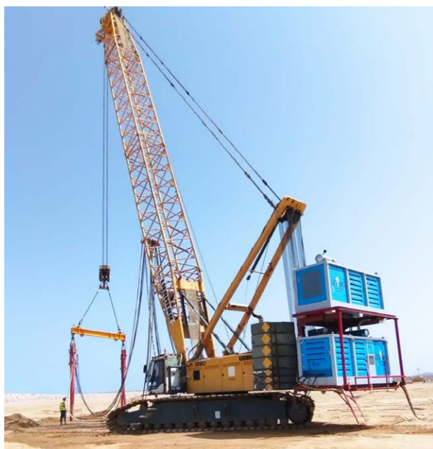
Opération de vibrocompactage pour la consolidation des sols
