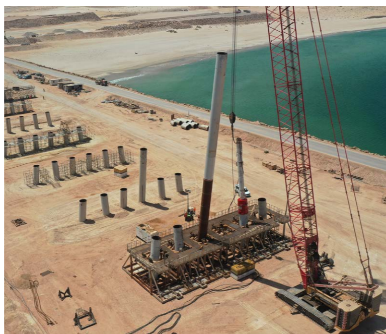
Battage des pieux dans le projet du Port de Dakhla Atlantique
