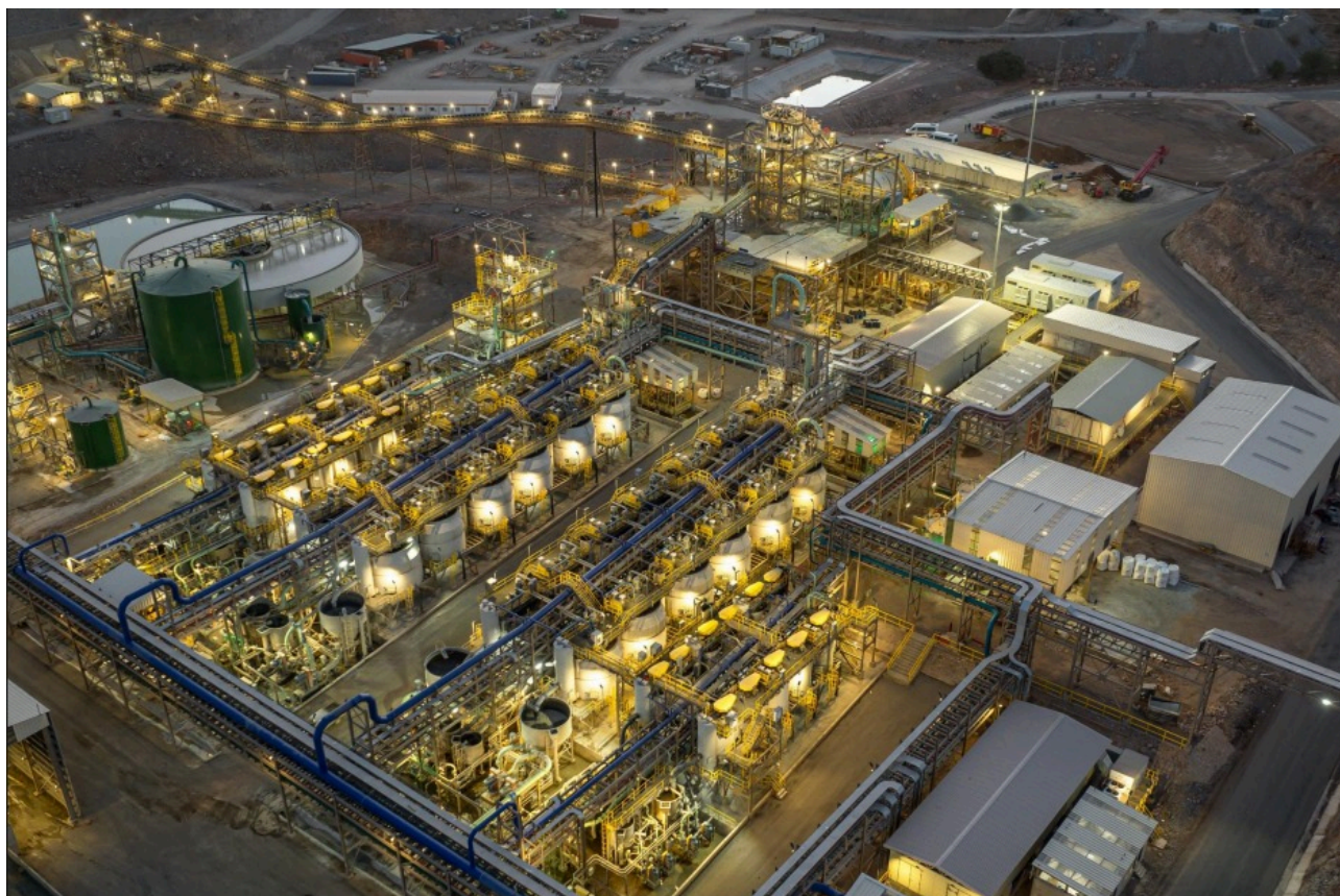
Montage d'équipements par STROC Industrie | Mine de Tizert (2025)
