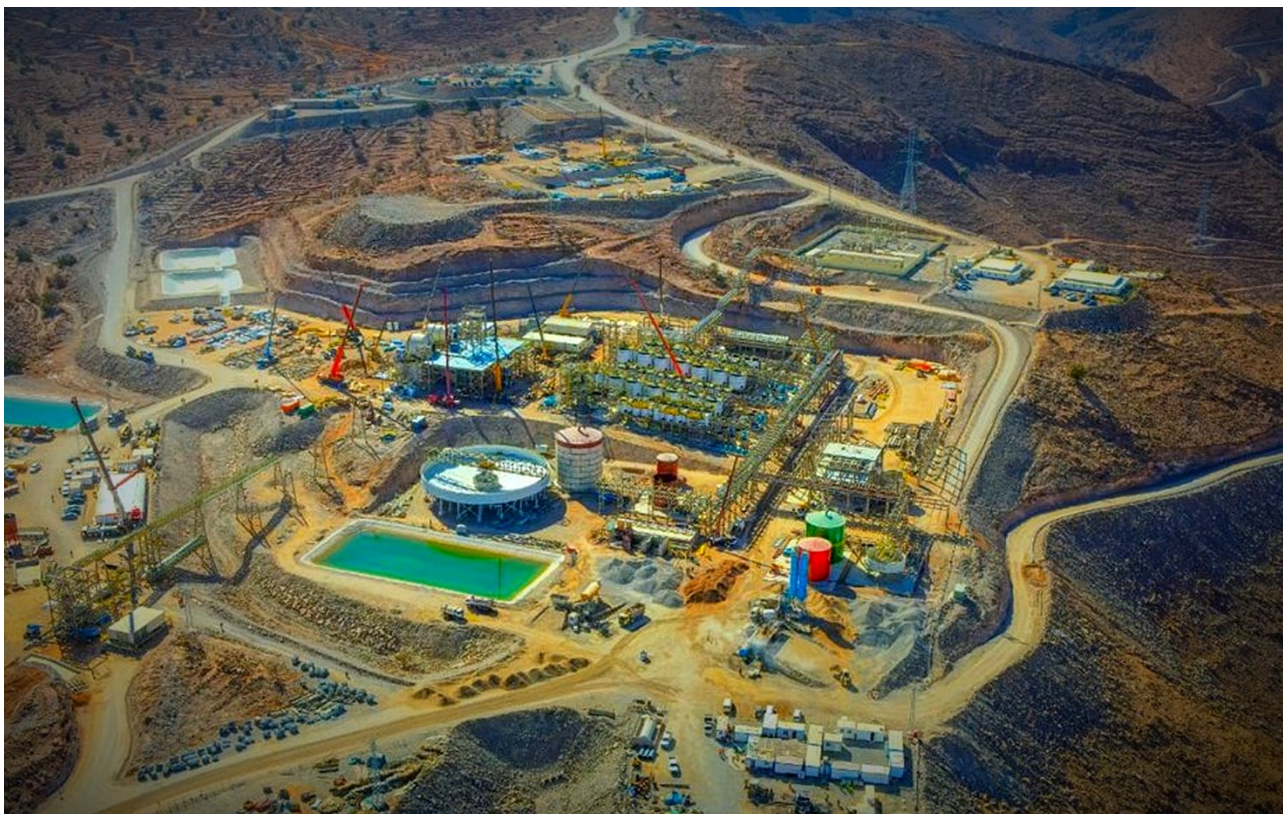
Montage d'équipements par STROC Industrie | Mine de Tizert (2025)
